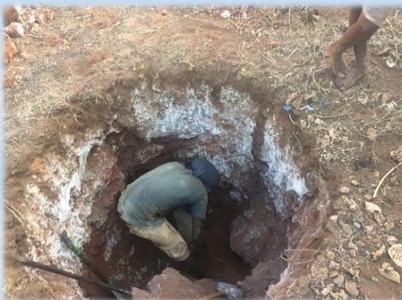
Über 27 Meter musste gegraben werden, was die Einwohner sehr interessiert verfolgten. Immer wieder mussten die Arbeiten nach Regenfällen unterbrochen werden, da dies zu gefährlich war. Ein Arbeiter lässt sich an einem Seil gesichert nach unten abseilen, was sehr riskant ist und bei einem Einbruch des Brunnenschachtes wenig Sicherheit bieten würde. Der Brunnenschacht wird Meter um Meter nach unten mit einer Zementschicht verputzt um ein Einstürzen zu verhindern.
