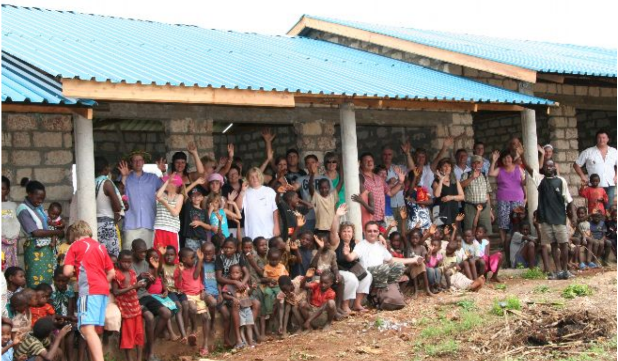
Foto: Besuch der Alibabas Primery-School in Vipingo. Die Reiseteilnehmer begutachteten den Baufortschritt welcher zu 100% aus Spendengelder durch VIPINGO e.V. finanziert wird.
